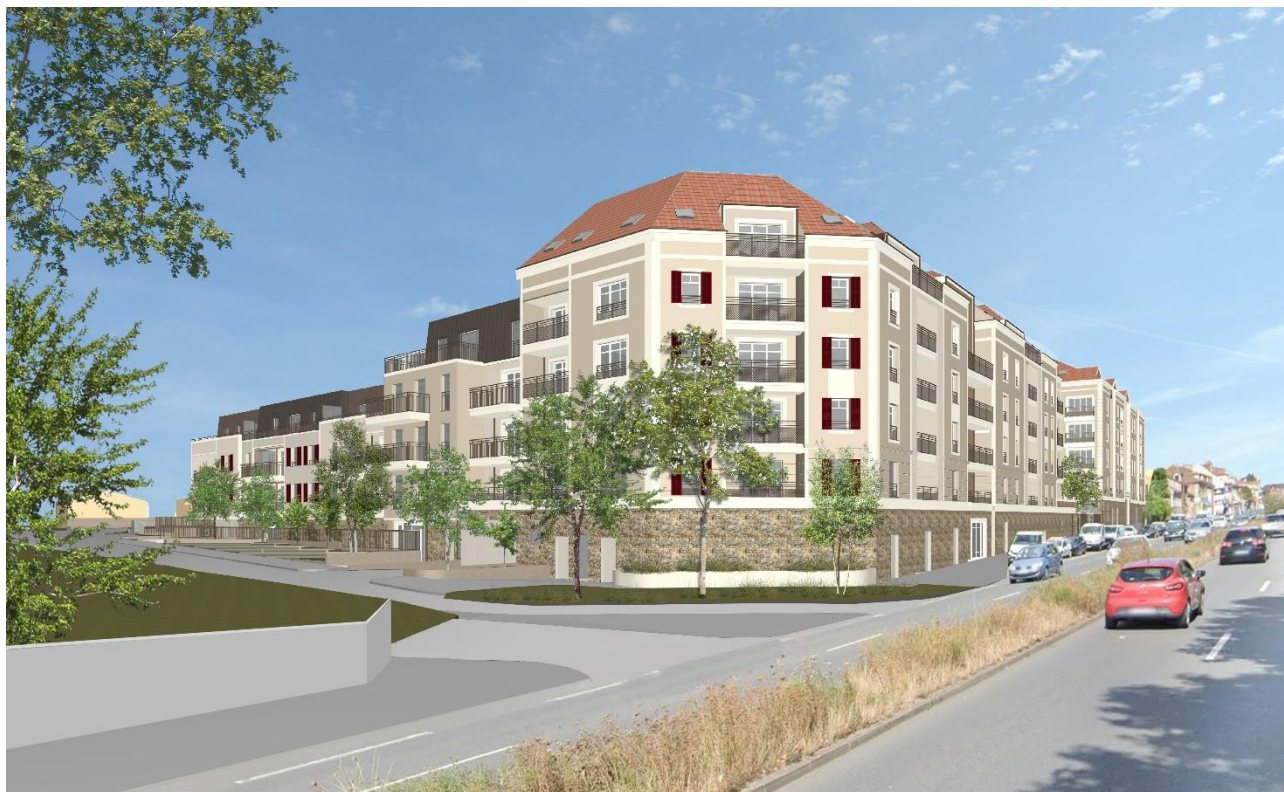
Figure 11 : APRÈS – Vue depuis la RN20 du chemin des Poutils et des accès aux bâtiments
